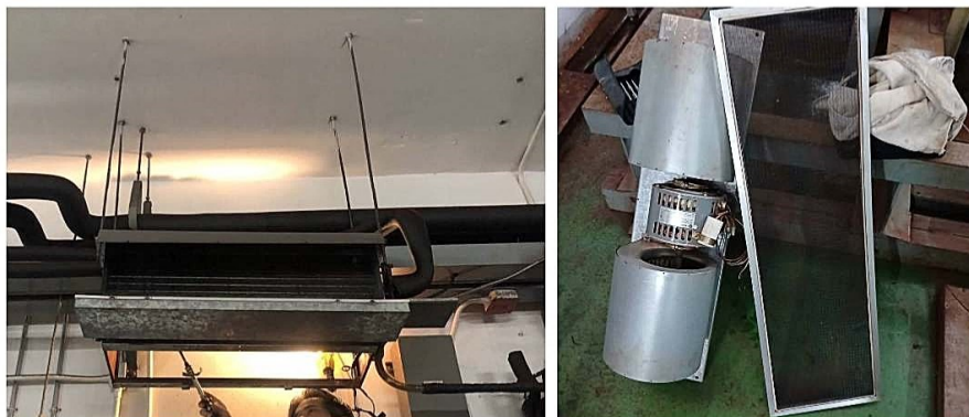
ภาพที่ 3-31 ทำความสะอาดเครื่องปรับอากาศ
